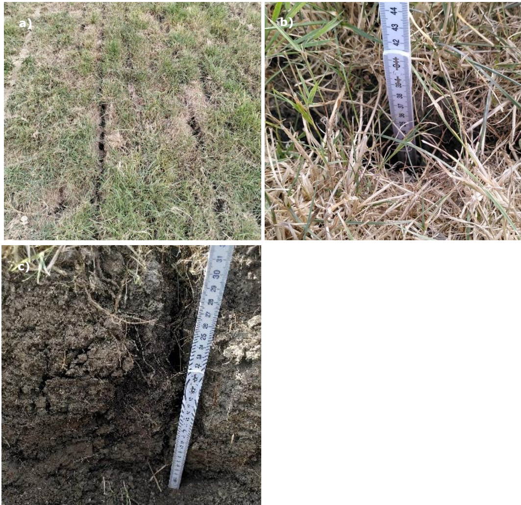
Figuur 5.1 a) Scheuren volgen de sleuven van de zodenbemester (KV); b) De duimstok meet in dit voorbeeld ongeveer 38 cm scheurdiepte (KV); c) scheuren lopen door tot in het schalterveen (KV, 6/9/22).
