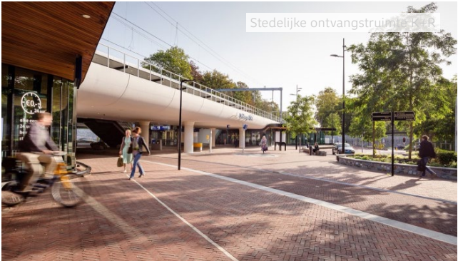
Station Driebergen-Zeist (ARCADIS)
