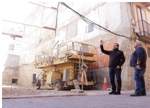
Carlos Sánchez (iza.) señala las labores de demolición de una casa del municipio
