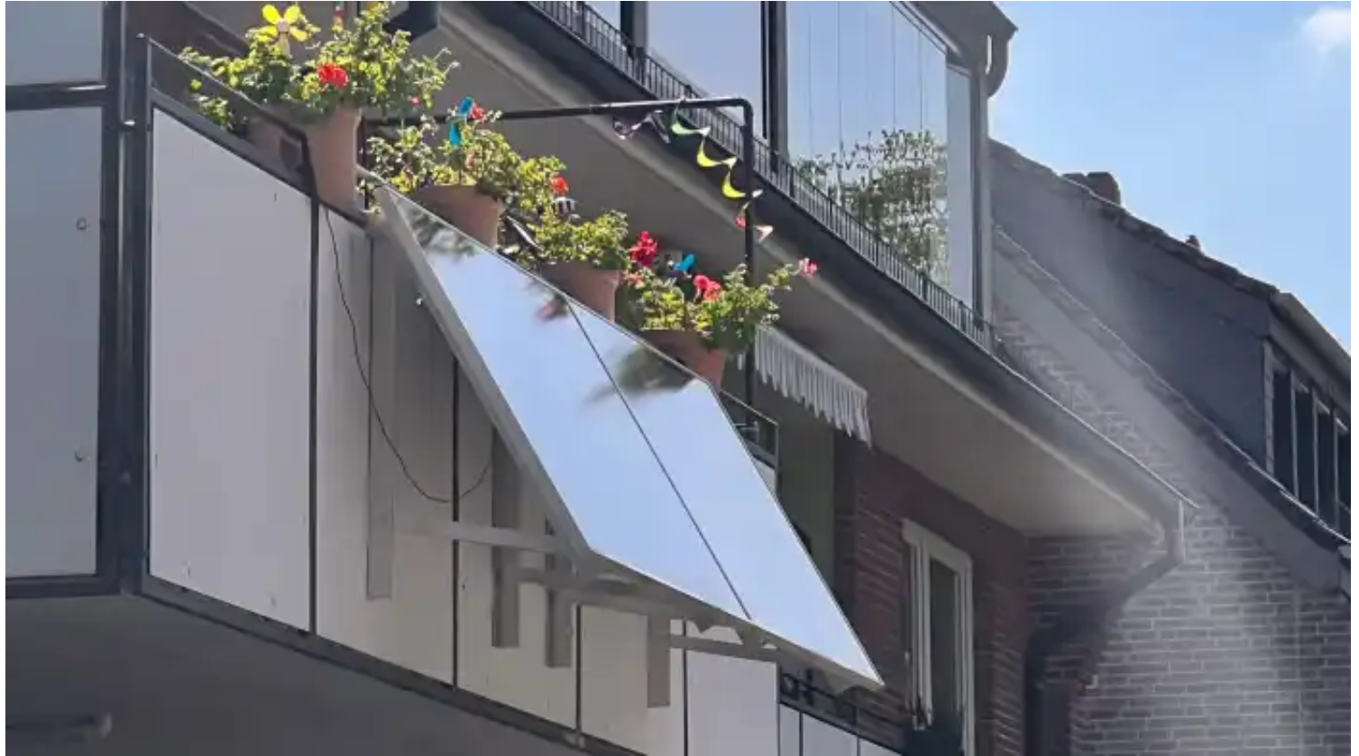
Balkonkraftwerk in Bremen
