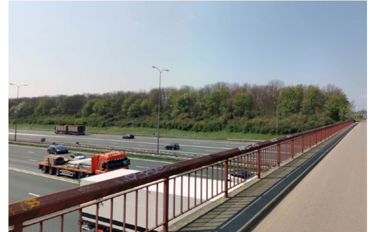
Brug Tussen de Rails: Verbinding over A27
